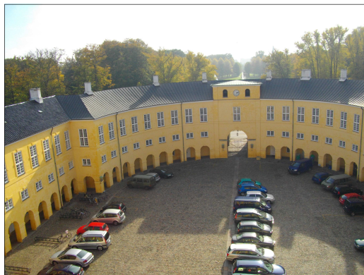
I flot efterårsvejr kunne vi nyde udsigten fra taget
